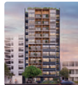
PORTA 360 MIRAFLORES EN CONSTRUCCIÓN
